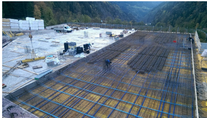
Esempio di solaio post-teso
