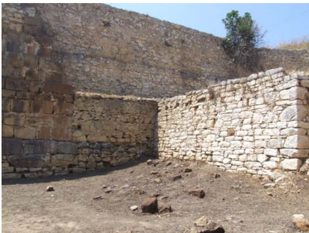
Fig. 7 Muro di delimitazione del canale
