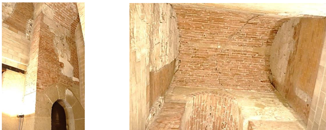
Fig. 5 Torretta nord – Vano (B3) – A sx, portalino d'accesso al pozzo; a dx, intradosso delle volte d'interpiano in grossi mattoni sui vani (B3) e (C3)
