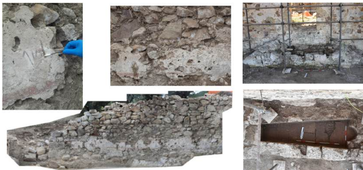
Fig. 25 Sala capitolare con resti di pitture parietali
