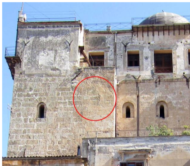
Fig. 9 Torretta nord - Fronte ovest
