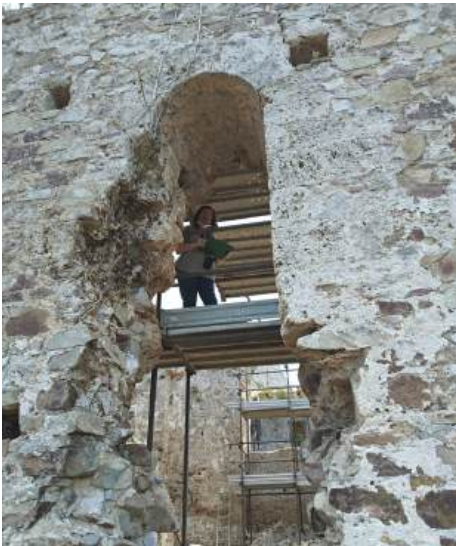
Fig. 1 Valeria Brunazzi sul ponteggio all'interno della chiesa
