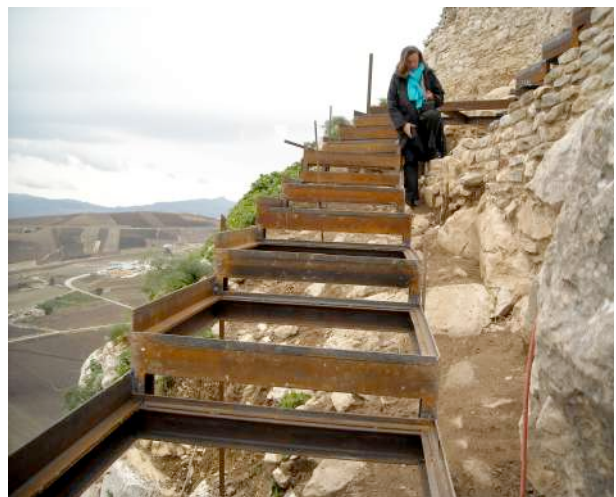
2008/12/17 - Castello di Maranfusa - Realizzazione della rampa di accesso
