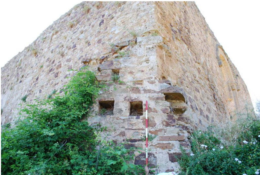
Fig. 26 Resti della struttura annessa alla chiesa, forse pertinente alle strutture del monastero
