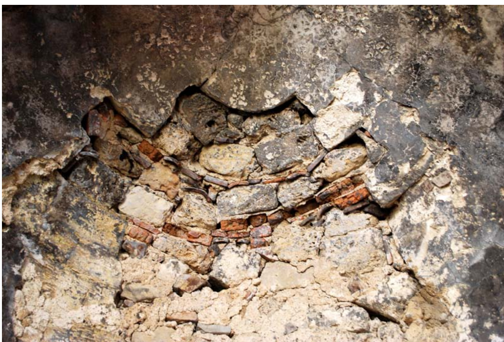
Fig. 25 Volta del catino absidale di destra con particolare della tecnica muraria
