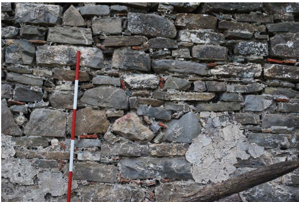
Fig. 17 Particolare della tecnica muraria rintracciata sul lato nord
