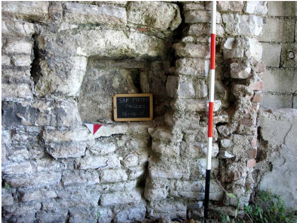
Fig. 13 Nicchia quadrangolare ricavata sul lato orientale del catino absidale
