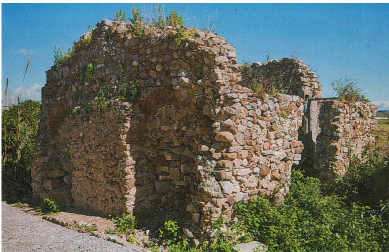
Fig. 1 Buonfornello. Resti di un mulino a ruota verticale edificato in mattoni in cotto, ciottoli di fiume e marmi di recupero
