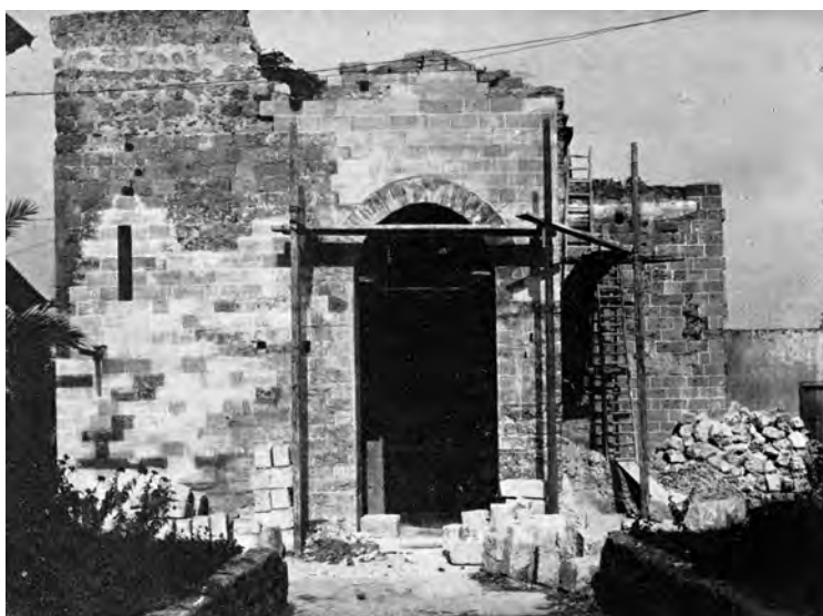
Fig. 4 La facciata in fase di demolizione a opera di Francesco Valenti
