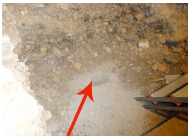
Fig. 2 Platea di fondazione dell'edificio
