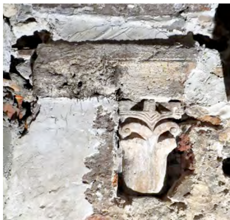
Fig. 5 Capitello incassato nella parete ovest
