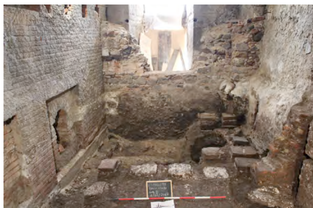
Fig. 2 Vano con suspensurae
