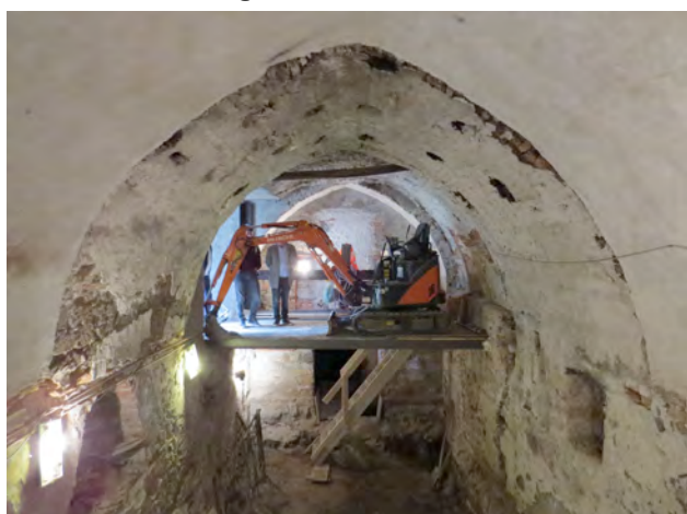
Fig. 3 Vano con volta forata
