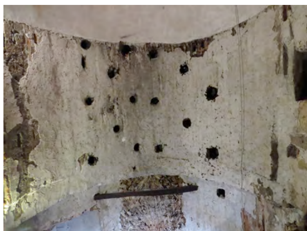
Fig. 4 Particolare dei fori nella volta
