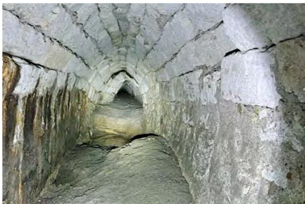
Foto E Il Canale del Papireto di via Gianferrara intasato fino alla volta
