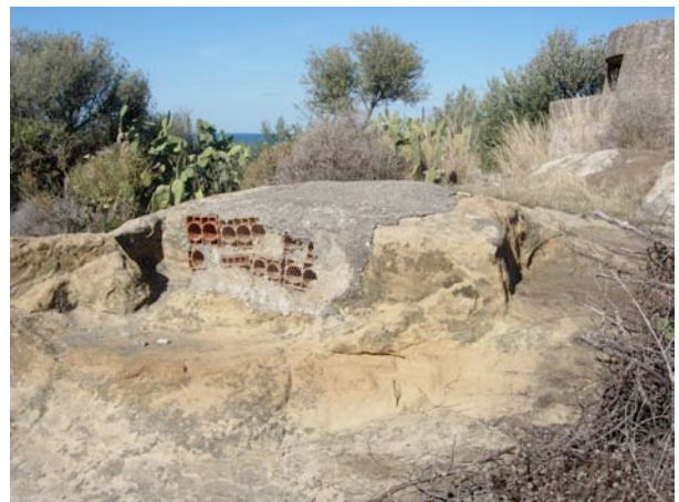
Fig. 40 Visione laterale delle foto precedente. Si noti il ricorso a mattoni traforati e cemento per chiudere l'apertura sommitale (foto Antonio Alfano)
