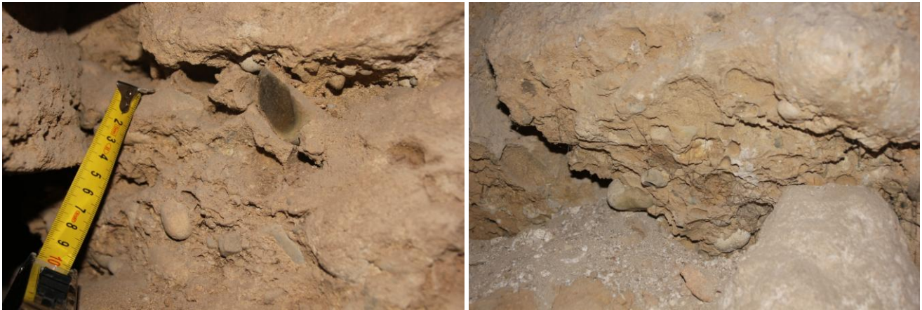
Figg. 4-5 Palermo, Palazzo Reale. Porzione di calcarenite conglomeratica nelle mura ellenistiche di Sala Montalto (foto: Ruggero Longo)
