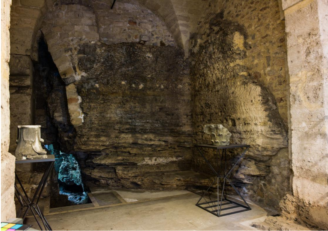
Fig. 9 Palermo, chiesa di San Giovanni degli Eremiti. Ambiente sotterraneo dove sono esposte le vestigia degli antichi fronti di cava, nei quali è visibile l'orizzonte paraconglomeratico del Pleistocene medio e le sottostanti calcareniti del Pleistocene inferiore (foto: Gaetano Alfano )
