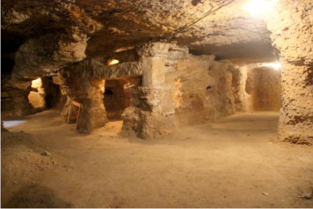
Fig. 11 Palermo, Catacombe di Via D'Ossuna. Gli ambienti ipogei risultano scavati negli strati calcarenitici del Pleistocene inferiore. Nei soffitti affiora invece l'orizzonte paraconglomeratico del Pleistocene medio (foto: Ruggero Longo )
