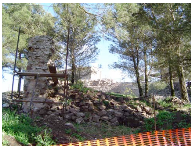
Figg. 37-38 Imposta della volta e relativo crollo dell'accesso, che collegava l'ala ovest con l'ala sud del castello
