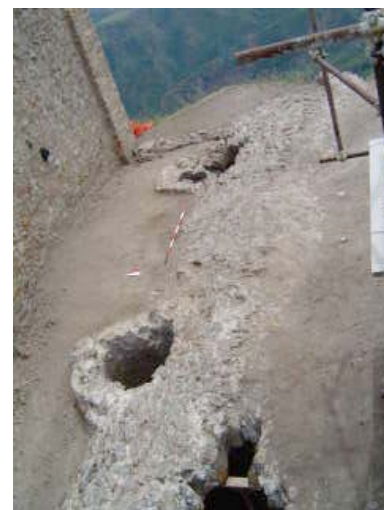
Fig. 26 Condotto che raccoglieva l'acqua piovana proveniente dal tetto nella cisterna
