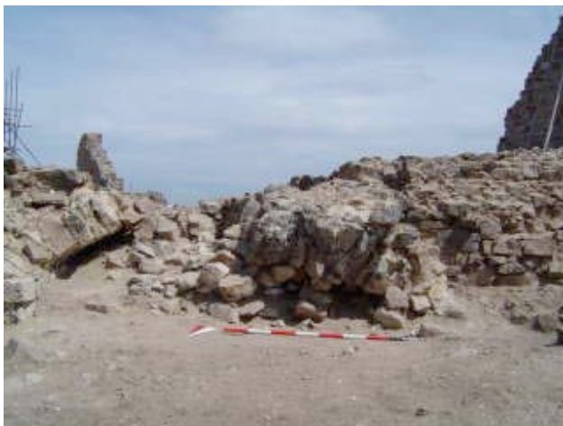
Figg. 37-38 Imposta della volta e relativo crollo dell'accesso, che collegava l'ala ovest con l'ala sud del castello
