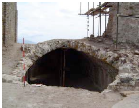
Figg. 27-28 Cisterna idrica irregolarmente pentagonale con copertura ad arco ribassato, orientata in senso E/O,; a destra la volta
