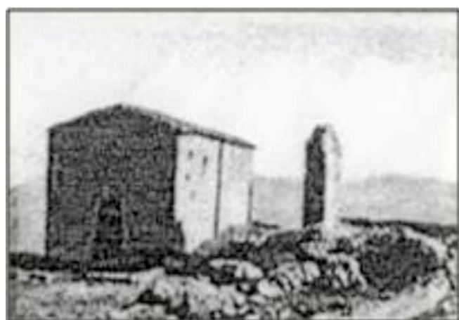
Fig. 10 Cartolina postale d'inizio '900 con ambiente voltato dell'ala meridionale ancora integro sulla destra
