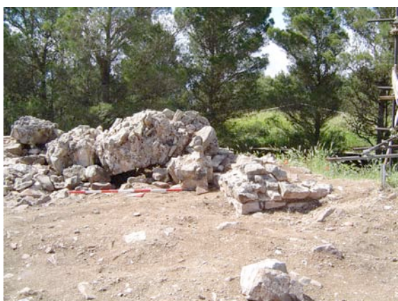
Fig. 35 Crollo della copertura voltata dell'accesso
