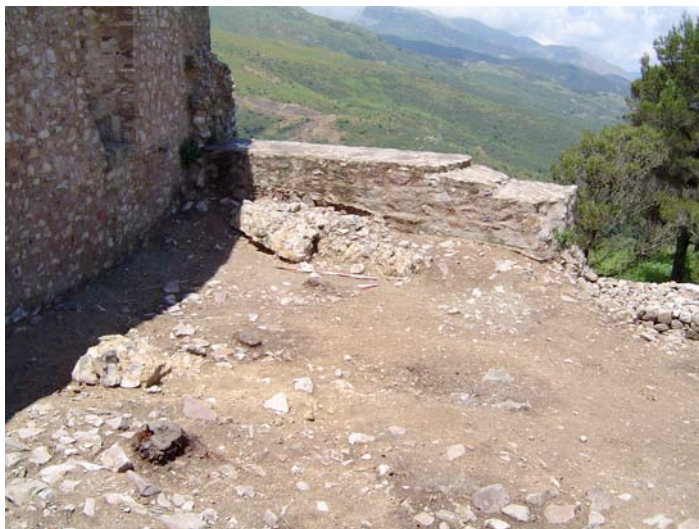
Figg. 12-13 Imposte delle volte e relativi crolli dell'ala occidentale
