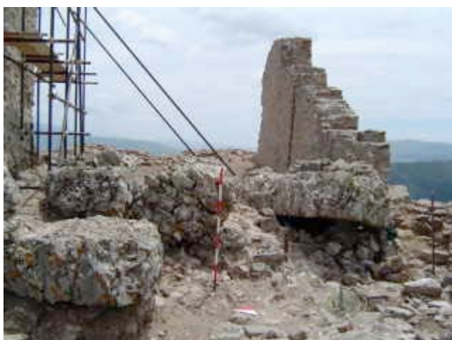
Figg. 8-9 Crollo delle coperture voltate dell'ala meridionale
