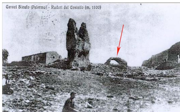
Fig. 36 Cartolina postale di inizio '900, in cui è visibile la principale volta dell'accesso ancora integra prima del crollo
