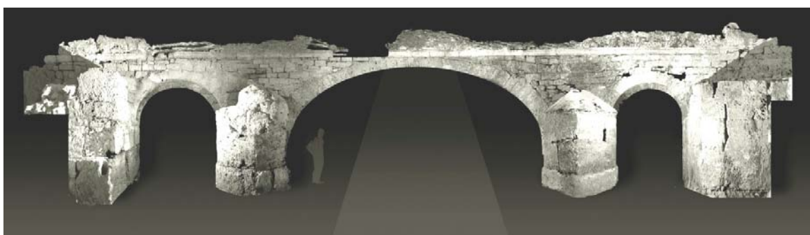
Fig. 30 Fotomosaico della fronte lato valle del ponte ritrovato a seguito degli scavi recenti (per gentile concessione della Sezione archeologica della Soprintendenza ai BB. CC. AA.)
