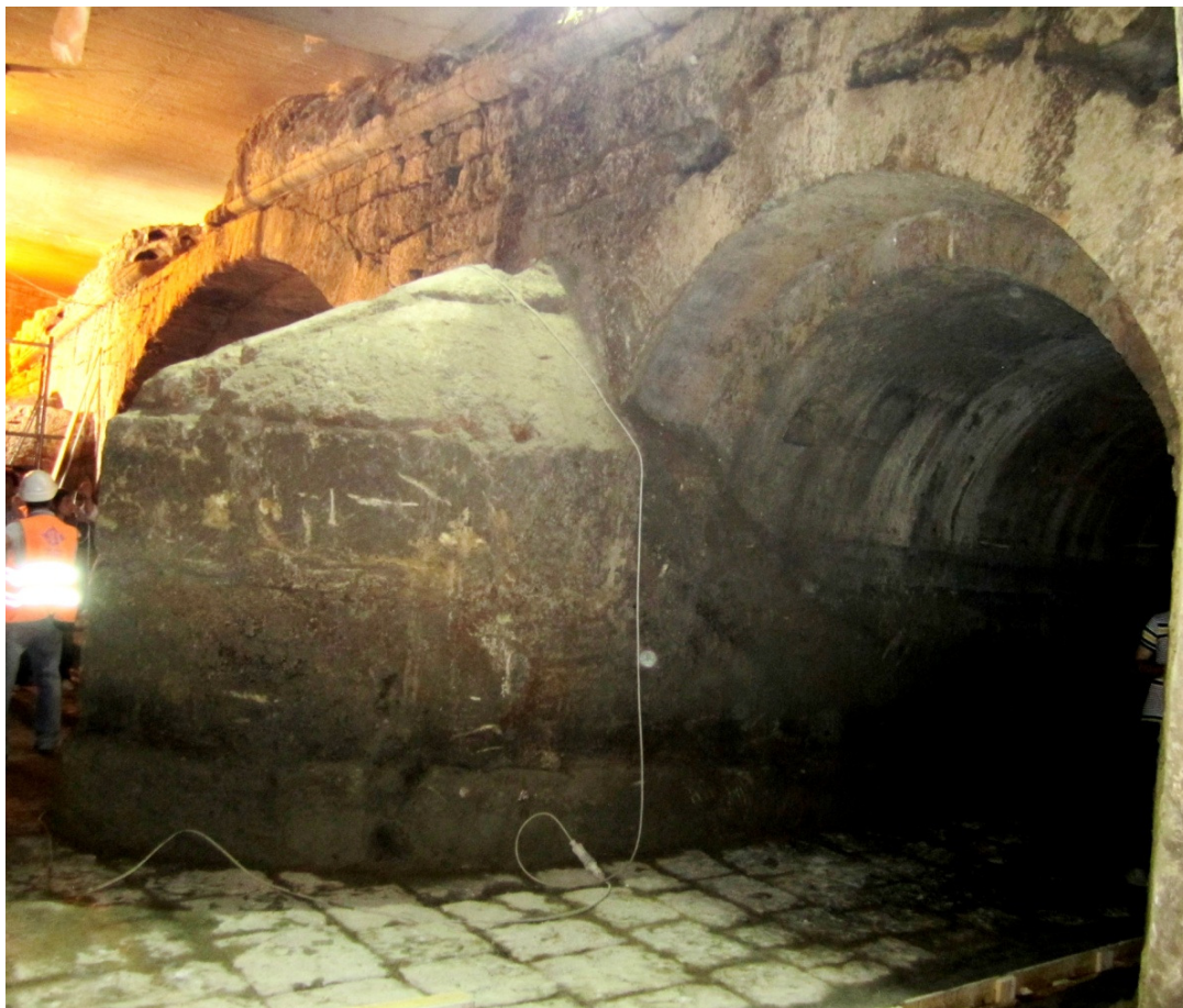
Fig. 31 Fronte lato valle del ponte con rostro sagomato e pavimentazione dell'alveo in lastre di calcareo compatto
