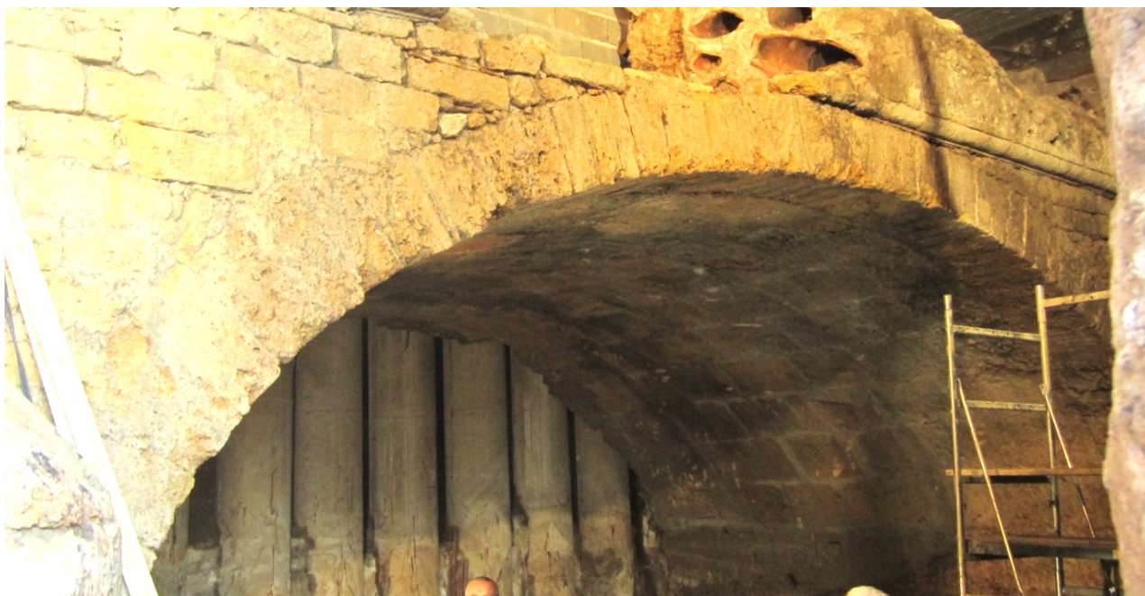
Figg. 35, 36, 37 Le immagini mostrano i pali in conglomerato cementizio armato di sostegno delle spalle del nuovo ponte bimodale (tram-autoveicoli), infissi nella zona centrale del ponte. Può notarsi la zona connotata da mattoni laterizi che vennero utilizzati per raccordare le parti di ampliamento del ponte rispetto a quelle originarie
