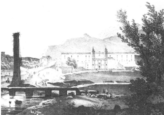
Fig. 12 Il "nuovo" ponte della Guadagna in muratura in una litografia dell'epoca, a più appoggi e poco elevato rispetto al pelo dell'acqua
