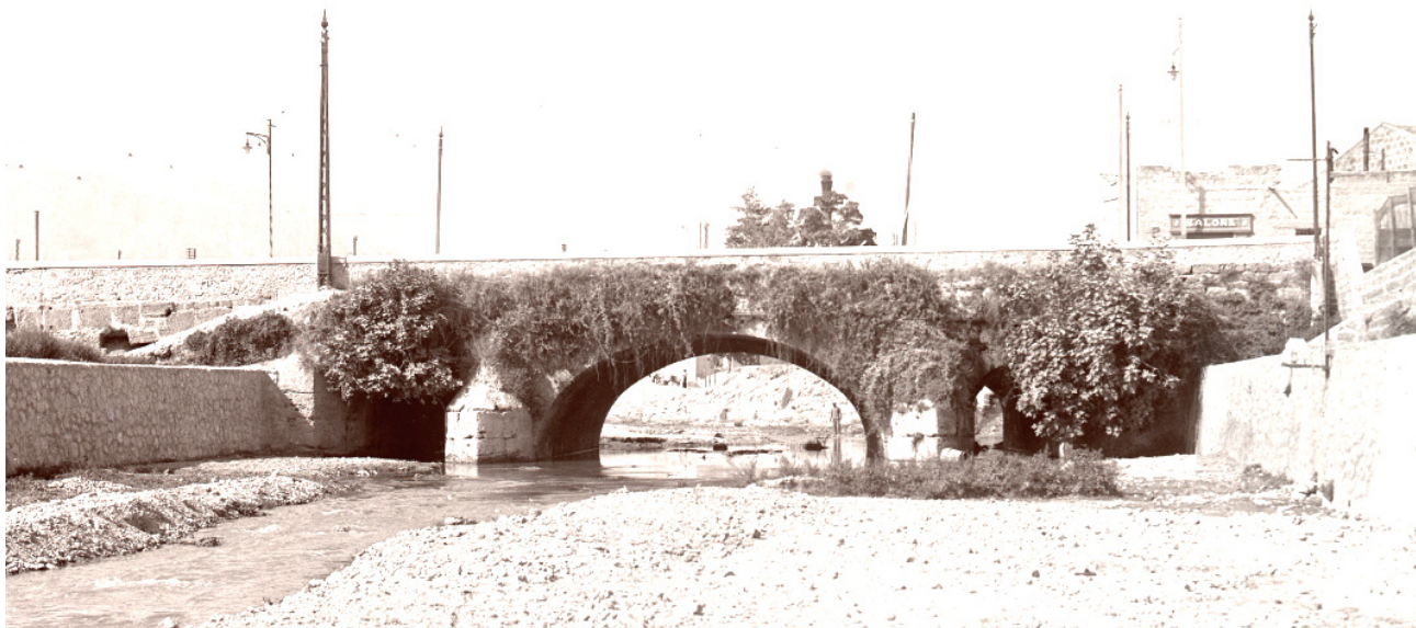
Fig. 25 Foto tratta dall'archivio Dante e Giuseppe Cappellani del ponte delle Teste, databile ai mesi precedenti l'alluvione del 1931. La vegetazione infestante ostruiva gran parte delle campate laterali
