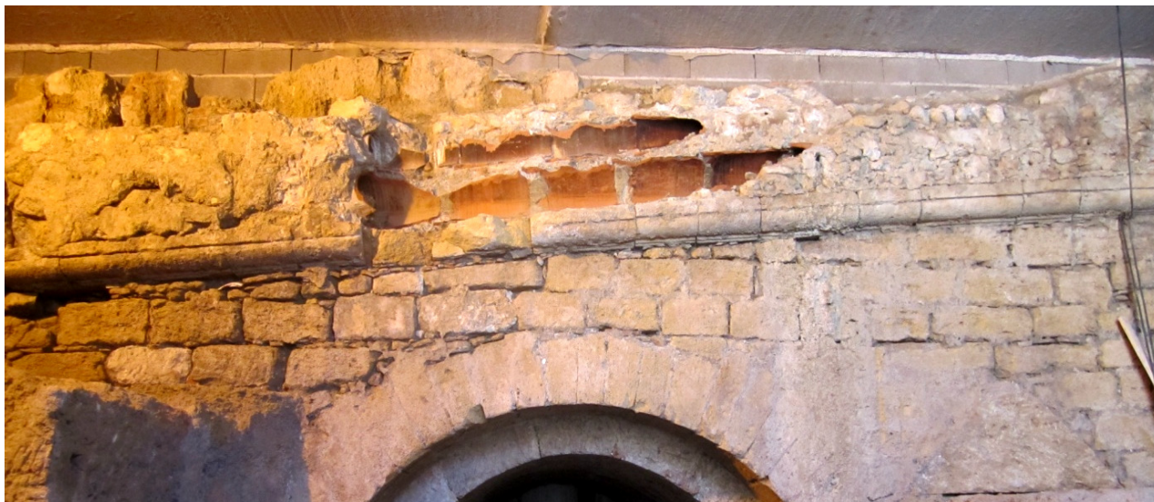
Fig. 33 Cordone in lunghi blocchi in calcarenite finemente intagliata, il cui andamento mostra l'originaria pendenza delle rampe
