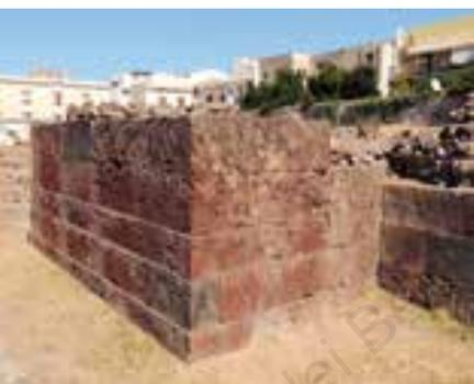
Soprattutto la torre di c.da Diana è formata da blocchi di dimensioni eccezionali e tutta la struttura ne trae un aspetto di grande solidità, pur non essendo destinata a racchiudere un ambiente, ma solo a formare una piattaforma, riempita dall'*emplecton* e forse da catene.
