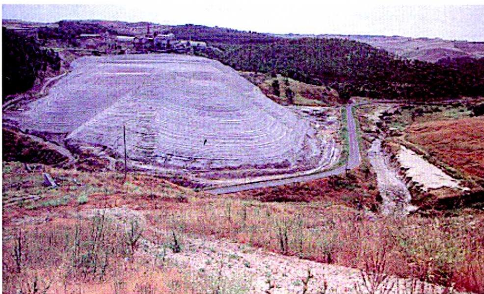
**La discarica di kainite della miniera Bosco. I *karren* si sono formati sulla superficie dei detriti, mentre l'inghiottitoio (non ancora presente nella foto) si è formato recentemente sull'unghia del rilievo in prossimità della strada.**
