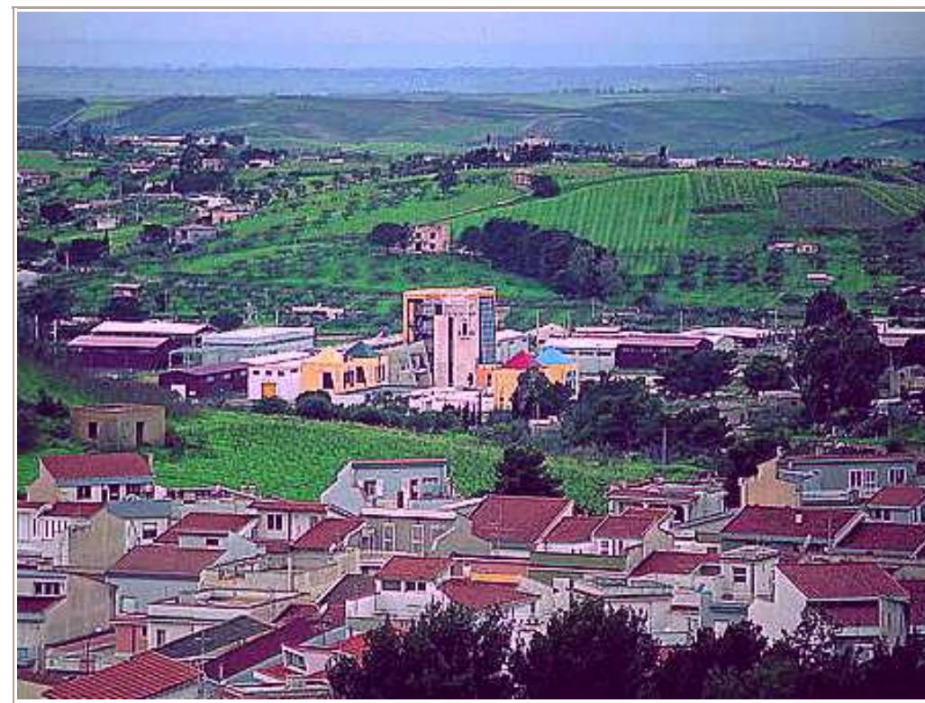
Una vista dell'abitato
