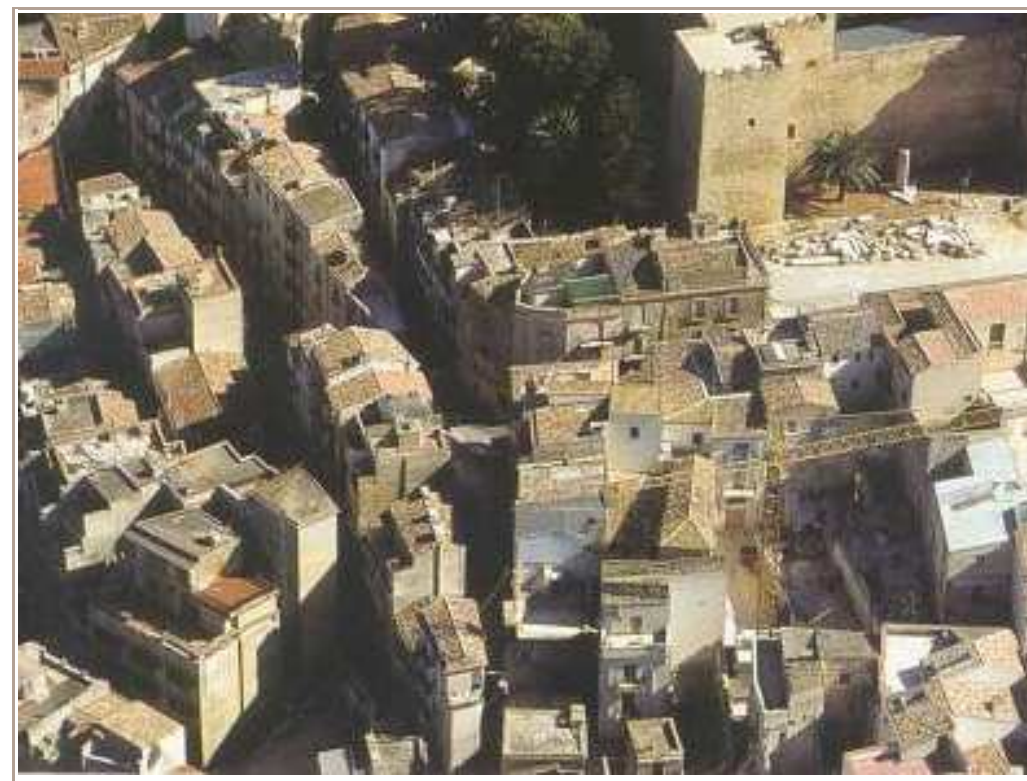
Particolare del tessuto edilizio
