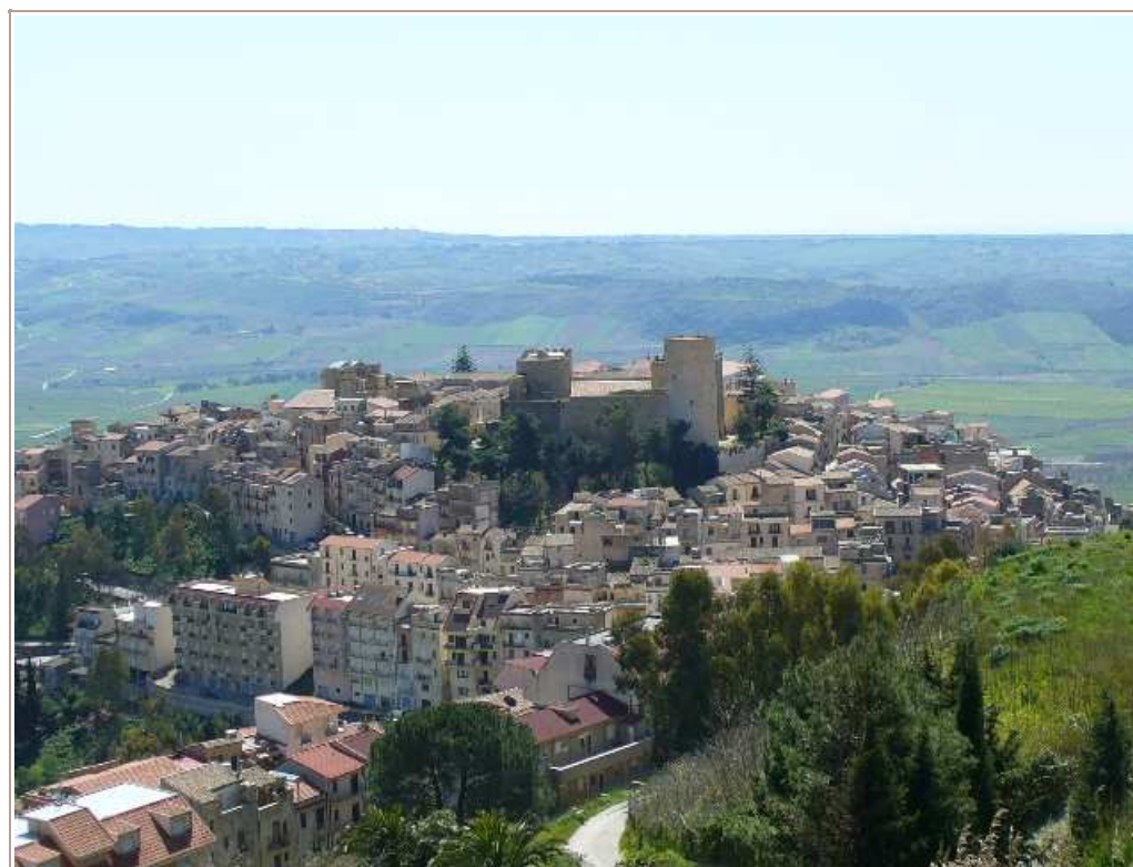
Vista panoramica del sito in cui sorge il castello dio Salemi
