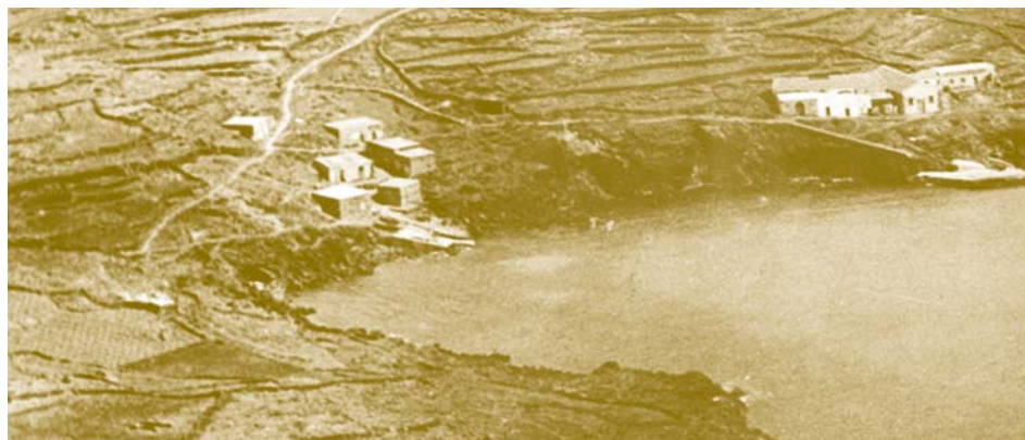
Fig.3 Pantelleria Baia di Scauri . Immagine d'epoca della Baia prima della costruzione del porto. Visibile il piccolo molo/caricatore nei pressi del quale si trova il relitto
