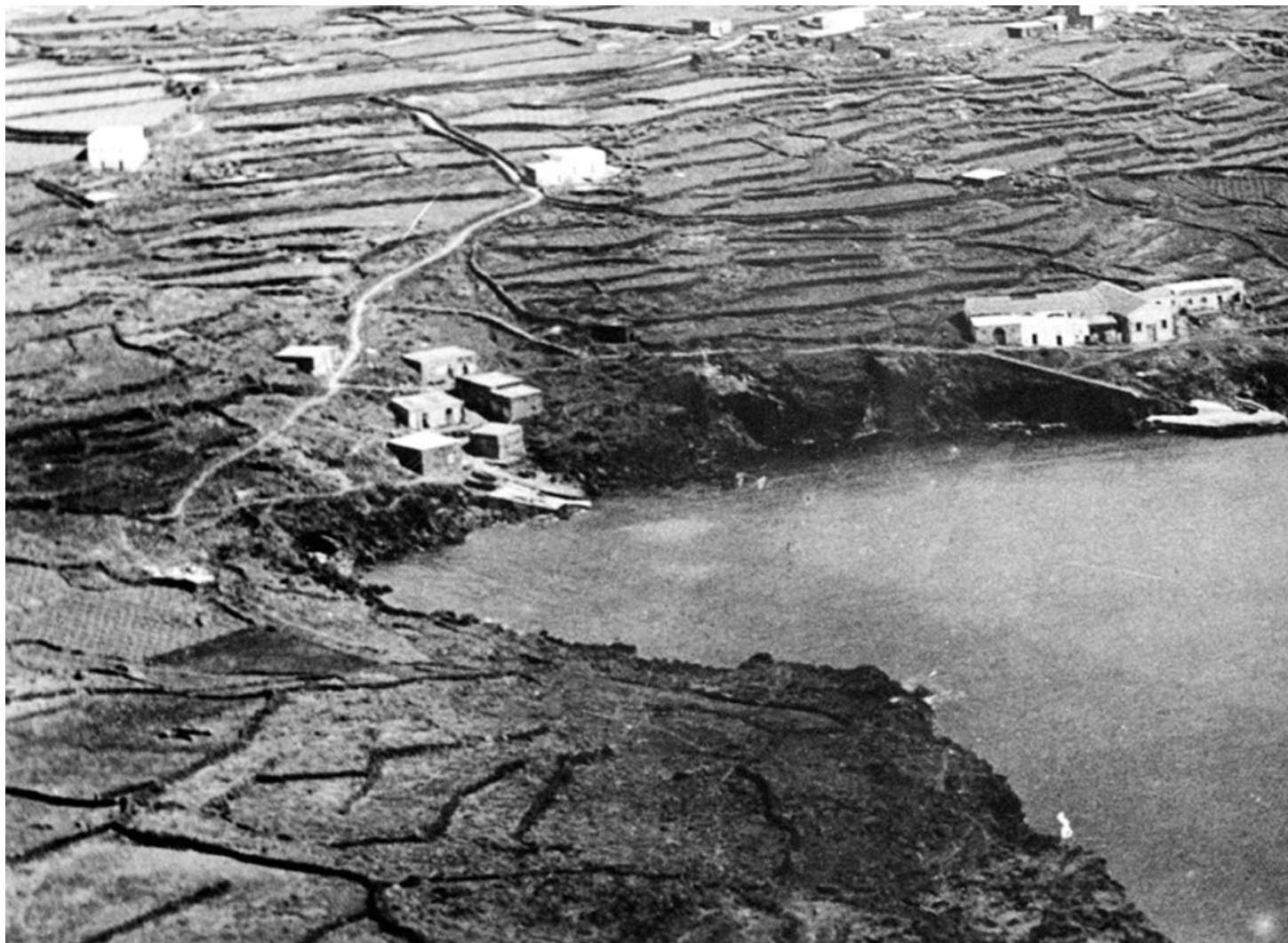
Fig. 1 Pantelleria Baia di Scauri. Immagine d'epoca prima della costruzione del porto.
