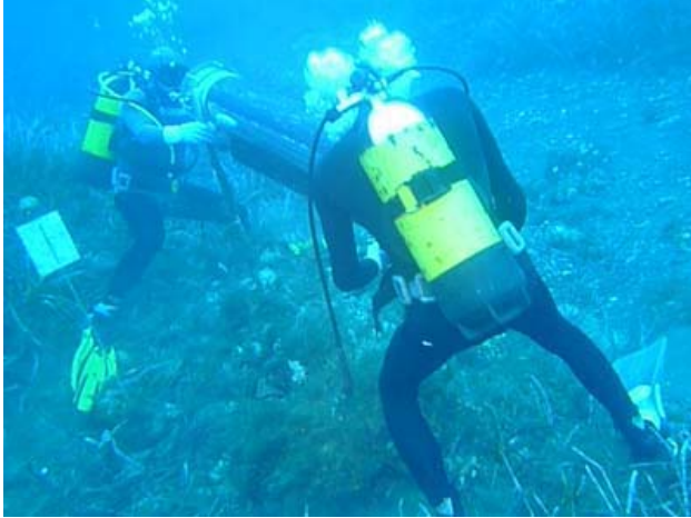
(I tecnici al lavoro a Gadir)
