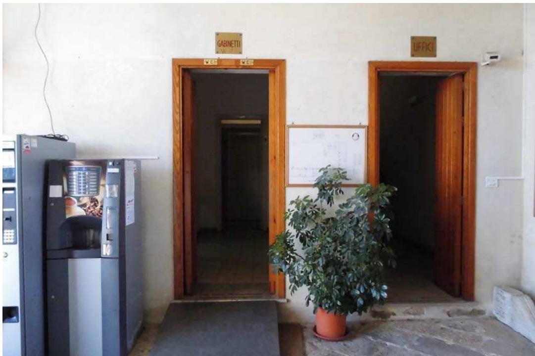
Foto 4: Vista prospetto galleria d'ingresso, servizi e collegamenti verticali per gli uffici.
