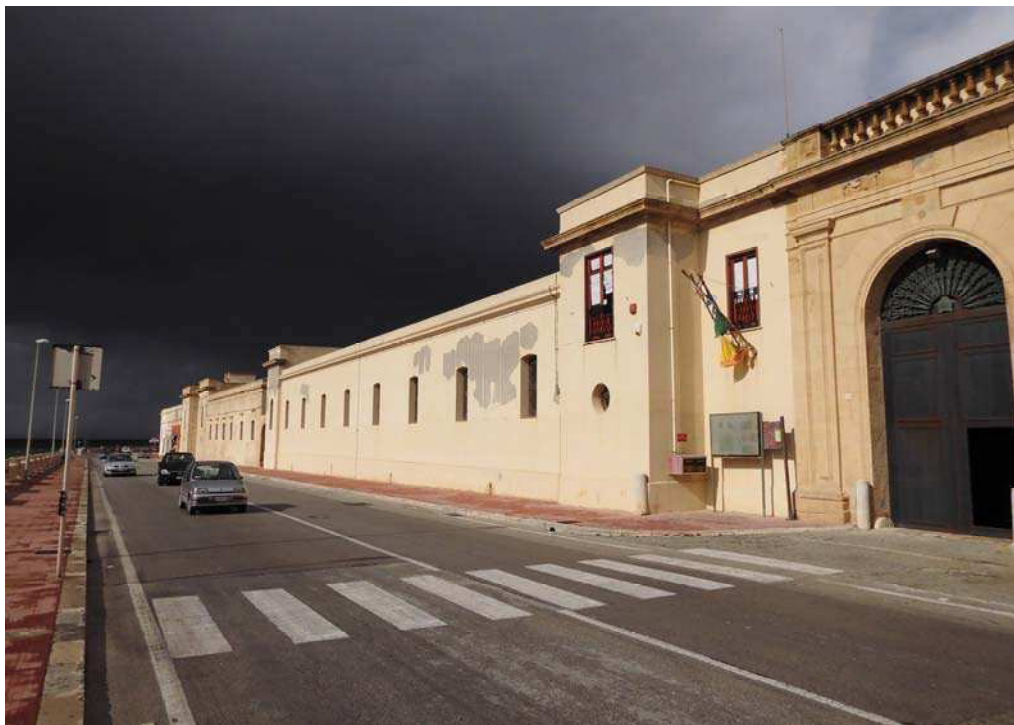
Foto 2: Vista del prospetto della Sala Lilibeo.
