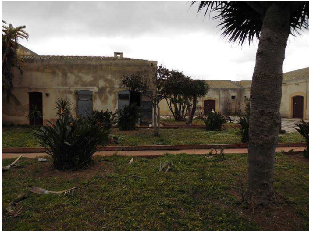
Foto 3: Vista, dalla corte, del prospetto interno del museo.
