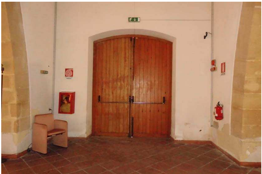
Foto 20: Vista uscita di sicurezza della sala.
