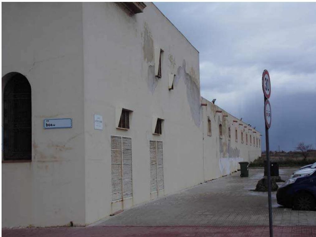
Foto 4: Vista del prospetto lato locale tecnico.
