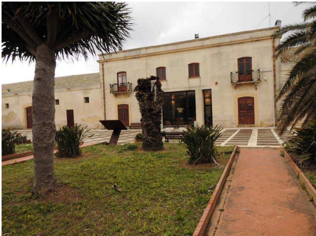
Foto 4: Vista, dalla corte, del prospetto interno del museo.
