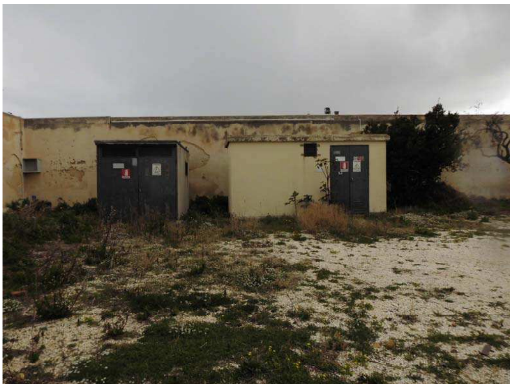
Foto 5: Vista cabine elettriche.
