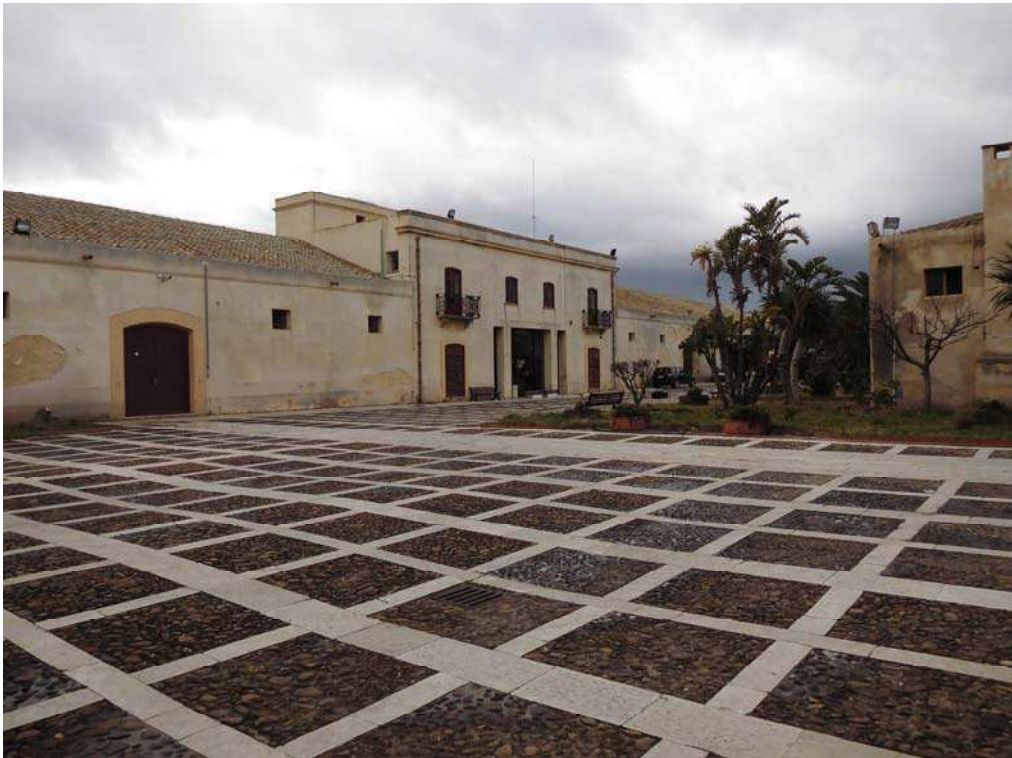
Foto 2: Vista, dalla corte, del prospetto interno del museo.
