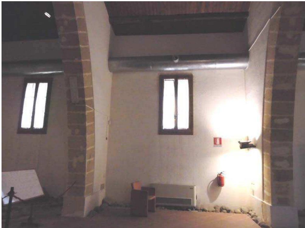
Foto 12: Vista settima arcata destra.
