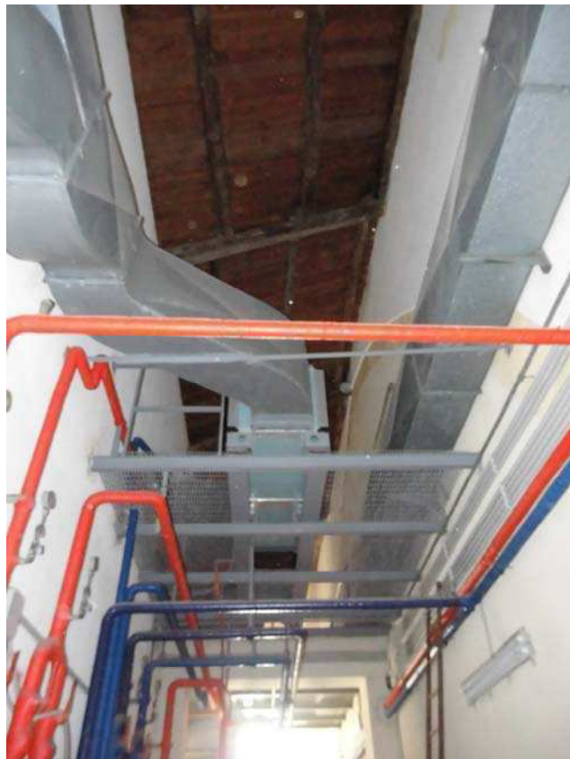
Foto 9: Vista del soffitto del locale tecnico.
