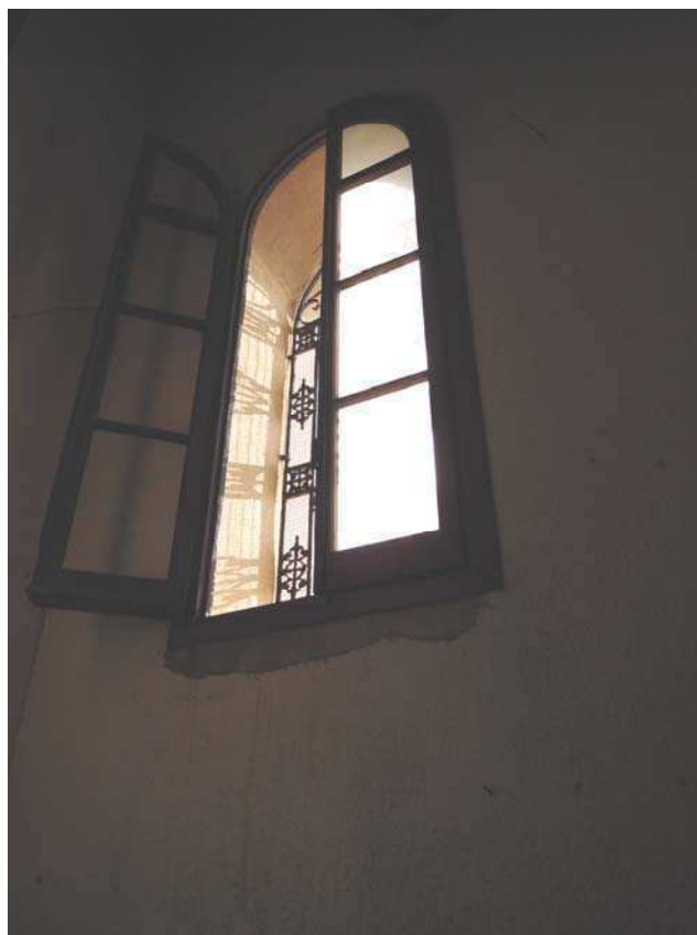
Foto 8: Vista della finestra situata alla fine del locale tecnico.
