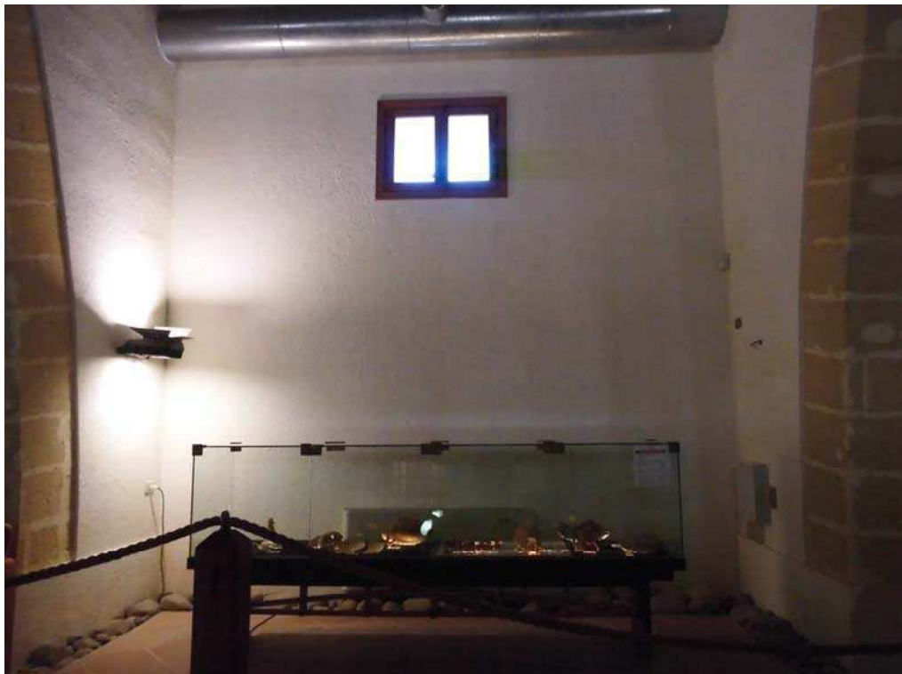
Foto 4: Vista quarta arcata sinistra.
