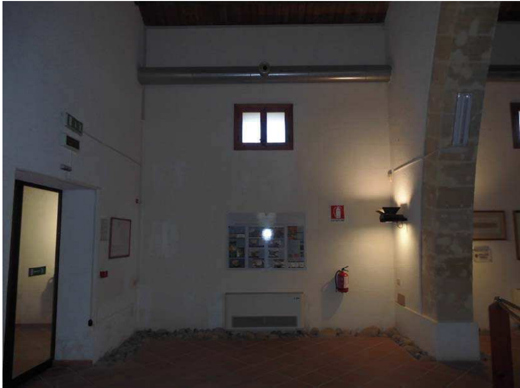
Foto 1: Vista prima arcata sinistra.
