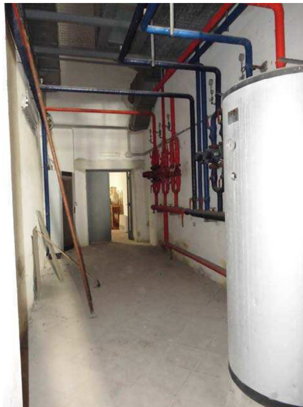
Foto 6: Vista dell'ingresso dall'interno del locale tecnico.
