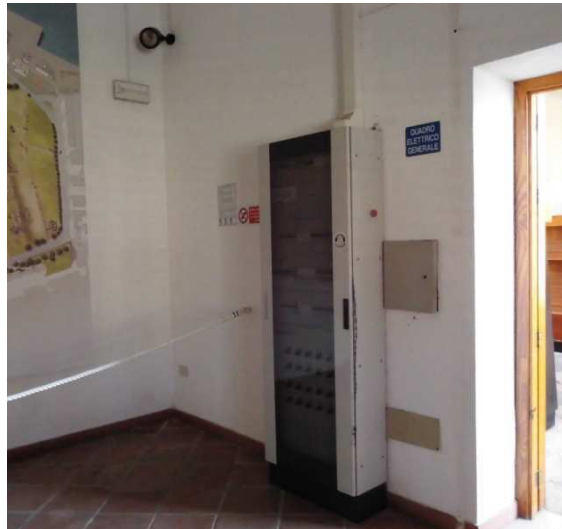
Quadro di zona della sala della Nave Punica
