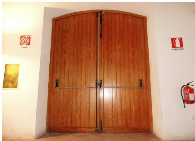
Vista dell'uscita di sicurezza e dei dispositivi di protezione dagli incendi
