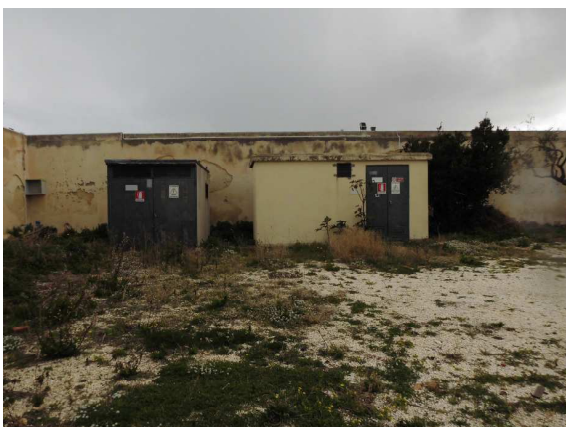
Vista cabine elettriche
