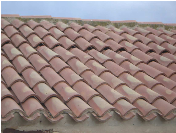
Esempio di scivolamento coppi
