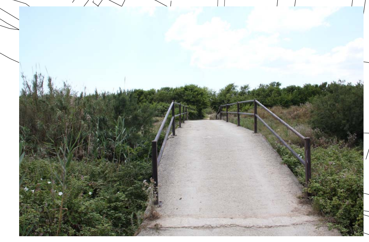
imbocco della passerella da ovest (stato attuale)
