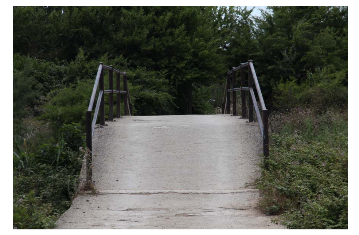
imbocco della passerella da est (stato attuale)
