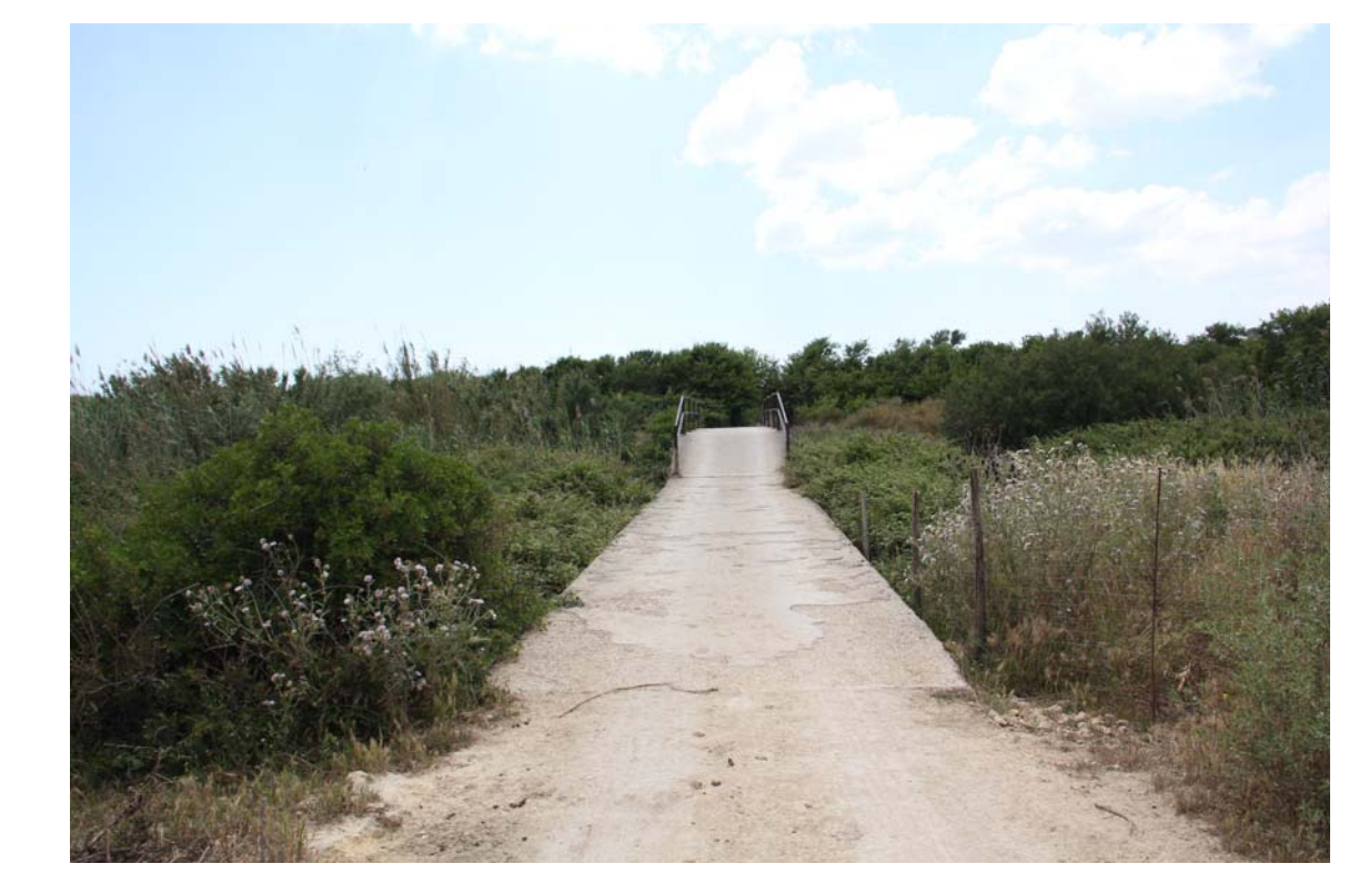
vista da ovest (stato attuale)
