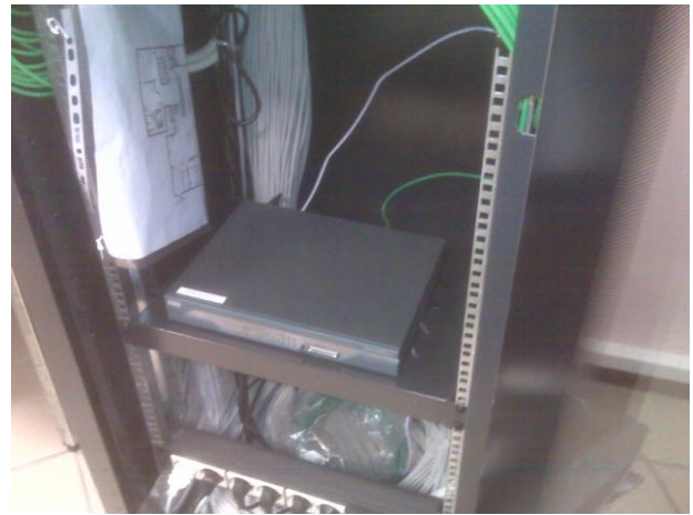
Vista del router dei cavi di arrivo e dei documenti prescritti all'interno dell'armadio
