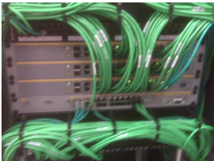
Qualità UTP6 per la realizzazione di un sistema informatico a norma
