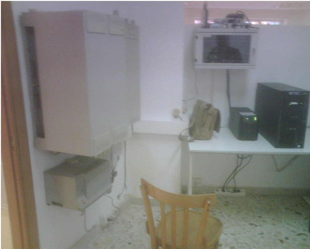
Realizzazione del centro stella e integrazione del cablaggio esistente
