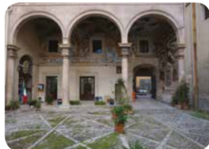
66 Archivio di Stato. Sede Gancia. Cortile d'ingresso
