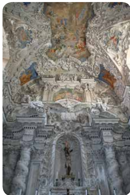
46 Chiusa Sclafani (PA), chiesa di S. Sebastiano, particolare degli stucchi
