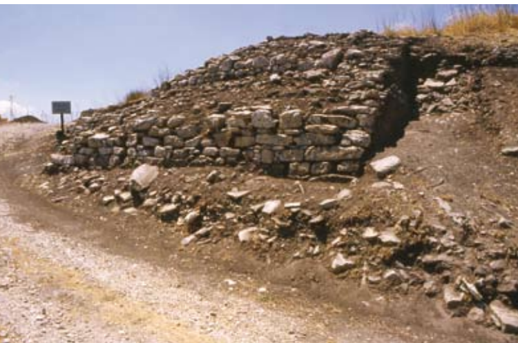
Accesso orientale: torre
