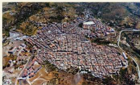
Fig. 1 - Veduta aerea di Valguarnera e posizione del sito
